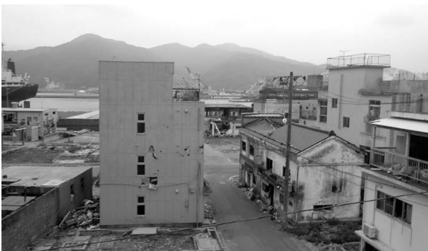
今後は被害を受けたまま残っている建物の解体時に、アスベストの飛散をどう防ごうかが焦点の一つになる
