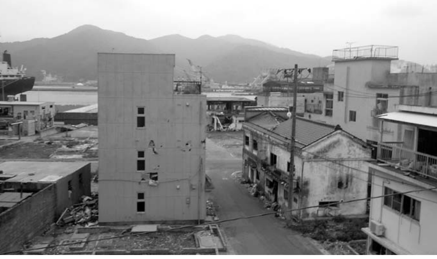
今後は被害を受けたまま残っている建物の解体時に、アスベストの飛散をどう防ぐかが焦点の一つになる
